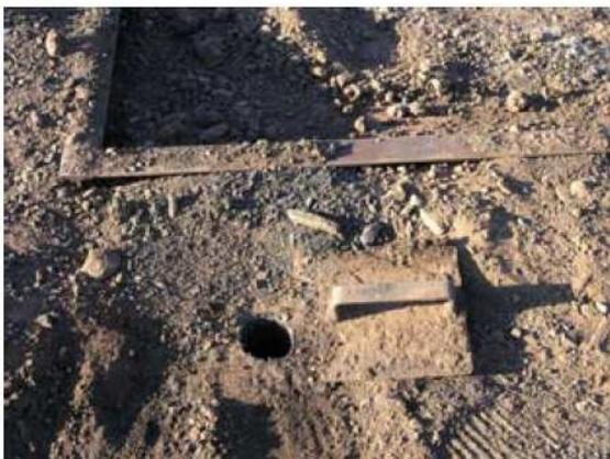
*Tronera inferior con tapadera en la parte exterior del horno*
